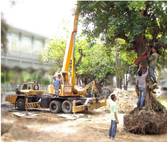
ภาพที่1 การยกย้ายต้นไม้ใหญ่ด้วยรถเครน
