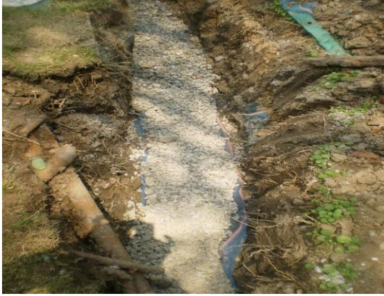
ภาพที่ 25 การขุดร่องระบายน้ำ ต้นคางคาเดือด
