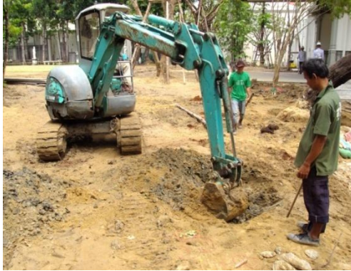
ภาพที่ 24 การเตรียมหลุมปลูก
